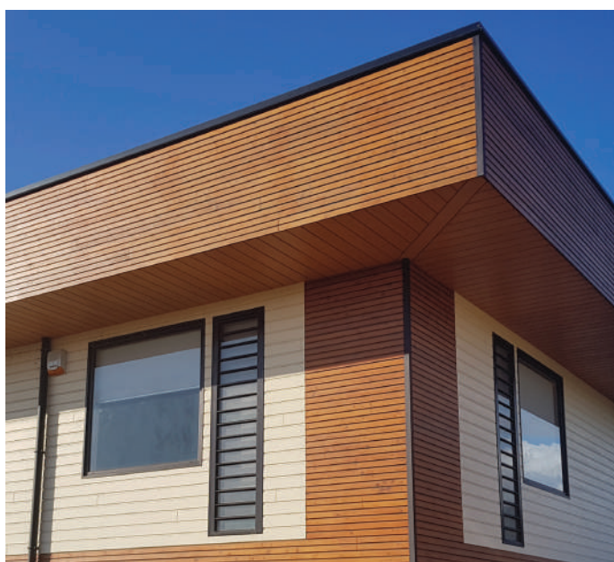
Openlam® mélèze - Profil 63 - Lasure mélèze et Funlam® Épicéa - Profil 21 - Pierre de Sarlat
