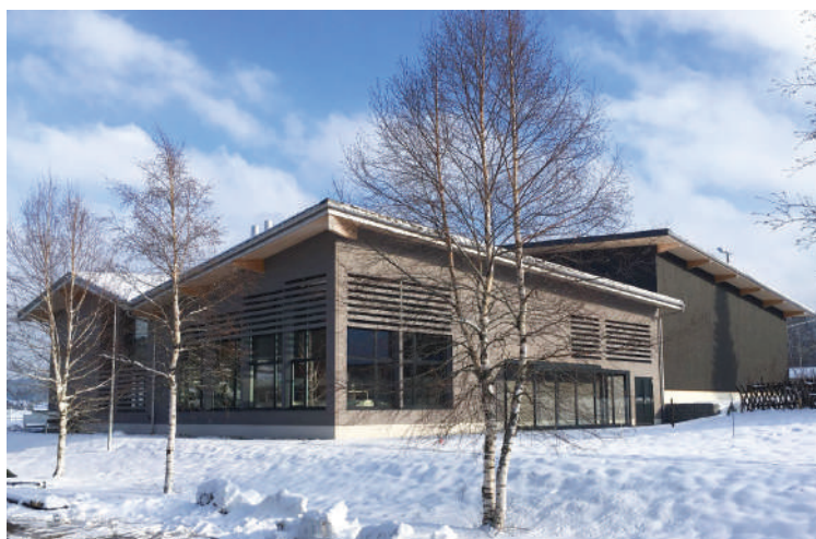
Funlam® épicea - Profil 21 - Saturateur gris clair et gris foncé
