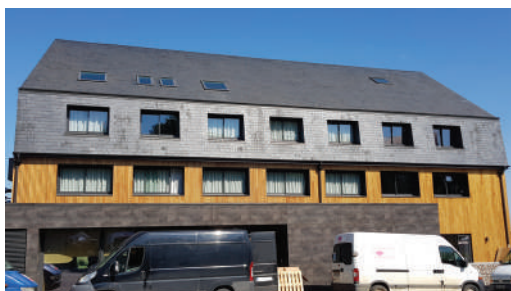
Openlam® mélèze - Profil 71 - Naturel avec fond de rainure noir
