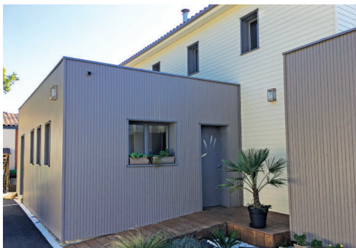
Funlam® épicea - Profil 21 - Peinture blanc perle C-s2, d0 et Openlam® épicea - Profil 73 - Peinture gris taupe C-s2, d0
