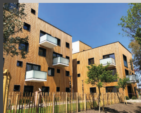
Openlam® mélèze - Profil 71 Naturel avec fond de rainure noir
