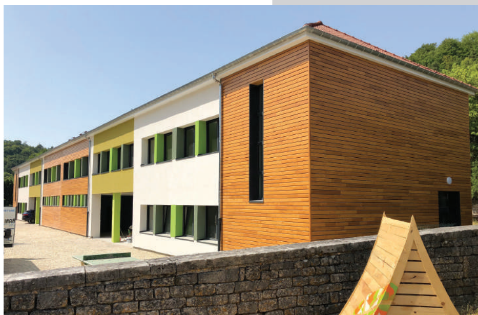
Openlam® mélèze - Profil 60 - Lasure mélèze avec fond de rainure noir
