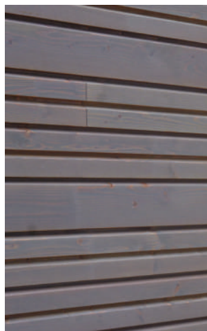
Openlam® mélèze - Profil 60 et 61 - Saturateur gris moyen
