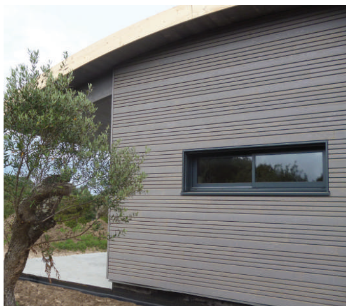
Openlam® mélèze - Profil 60 et 61 - Saturateur gris clair
