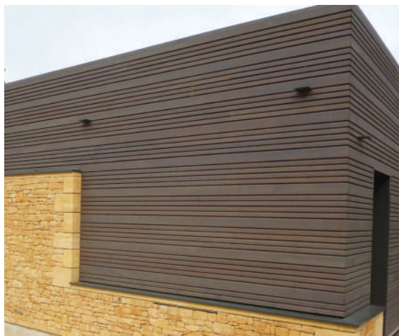
Openlam® mélèze - Profil 60 et 61 - Saturateur gris moyen
