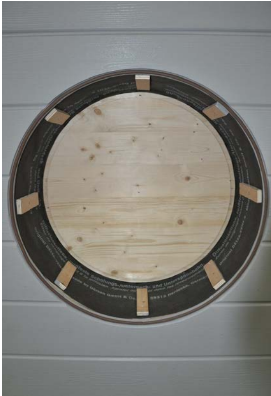
vue extérieure avant pose de l'encadrement
