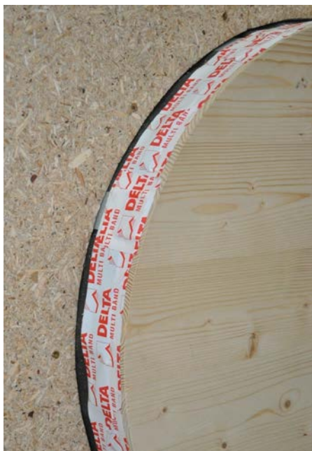
Fixation de la menuiserie avec les pates puis étanchéité avec du scotch
