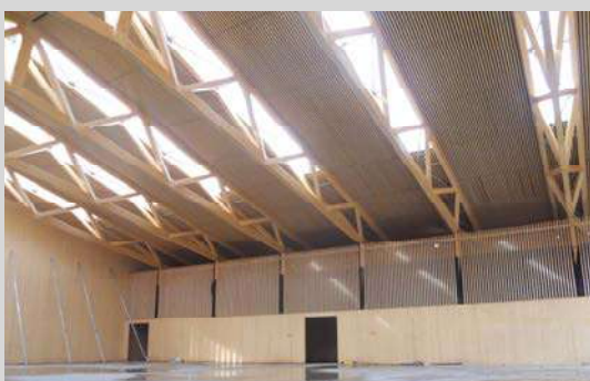
Longueil-Sainte-Marie (France) Glulam structure with Résix® connections
