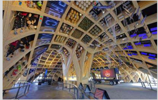
Glulam beams with Résix® connections
