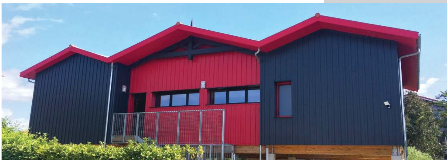
Planches brossées 25 x 210 mm et couvre-joints de section 21 x 68 mm, couleur gris anthracite et rouge framboise
